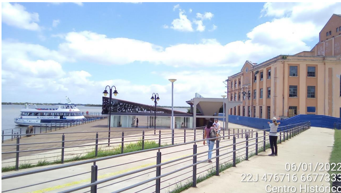
Foto 53: Acesso à Usina do Gasômetro. Fonte: ANX Engenharia e Arqueologia, 2022.
