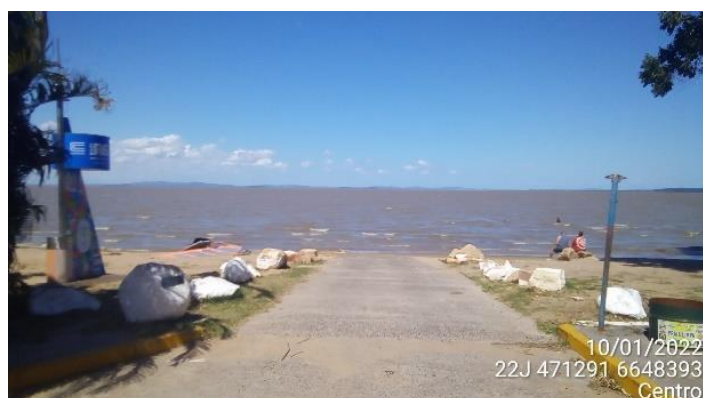
Foto 11: Orla Central da Barra do Ribeiro. Fonte: ANX Engenharia e Arqueologia, 2022.
