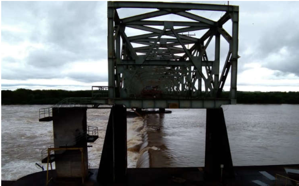
Figura 3.16 - Barragem de Amarópolis.
