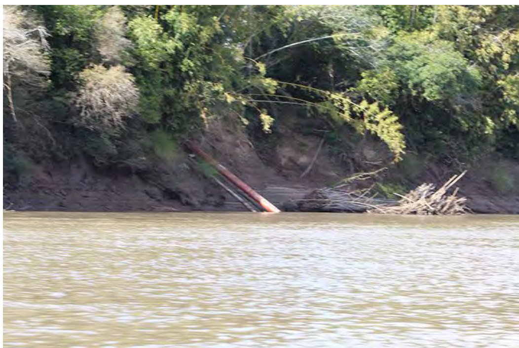
Figura 5.32 – Imagem obtida na margem esquerda do rio Jacuí, ponto 095, ilustrando uma das tantas tomadas d'água existentes.
