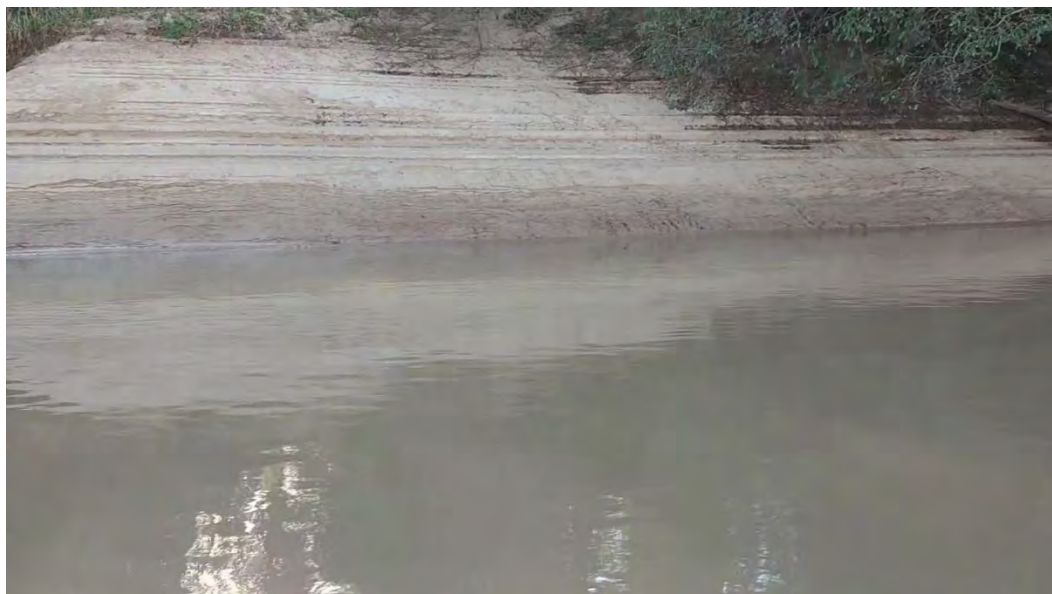
Figura 5.23 – Dique marginal, margem esquerda (Ponto 064).
