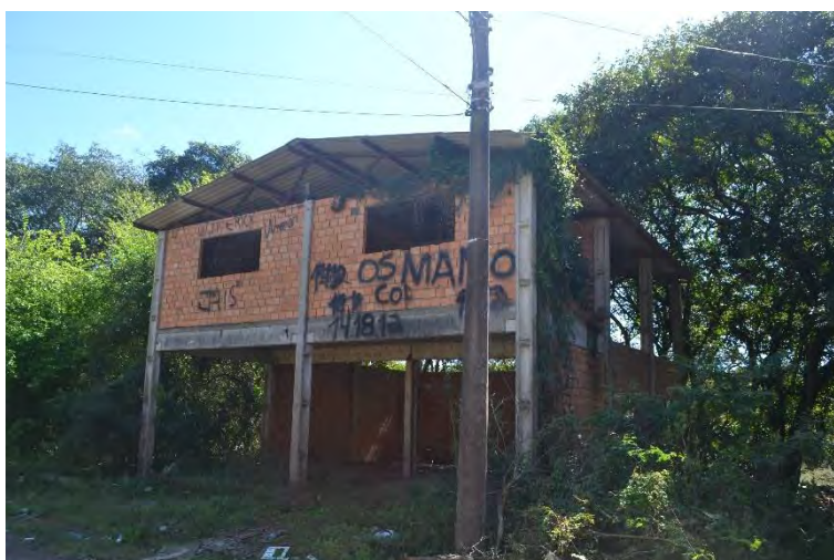
Figura 10.27 – Futuras instalações da associação (lat -29.951471° long -51.635155°). Fonte: Registro realizado em campo (Setembro/2019).
