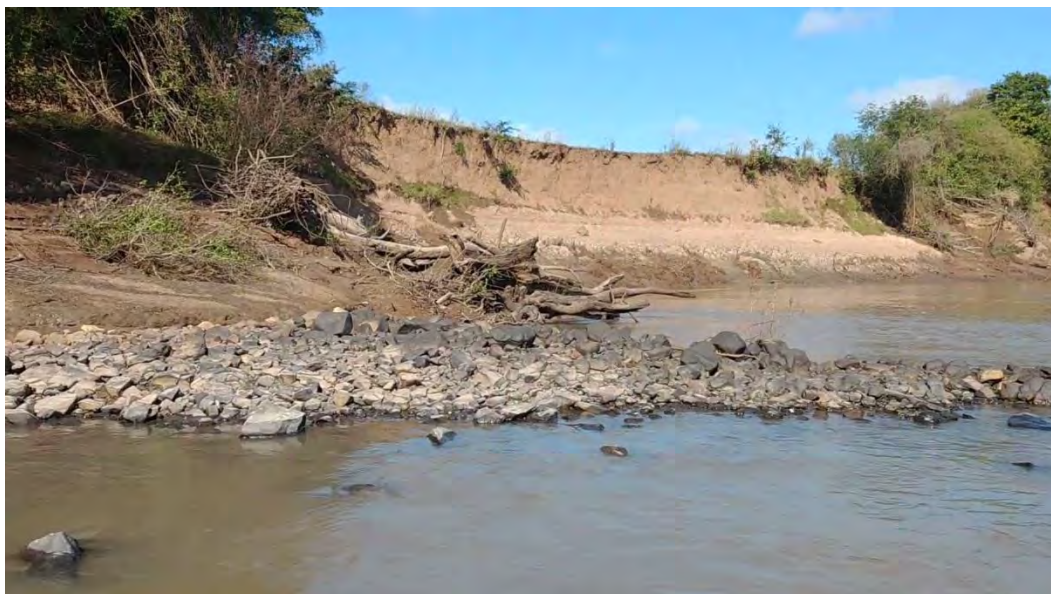
Figura 5.15 – Ponto 84 na margem esquerda (margem erosiva) onde se observa o dique em primeiro plano e a margem com processo erosivo e sem vegetação na porção erodida.
