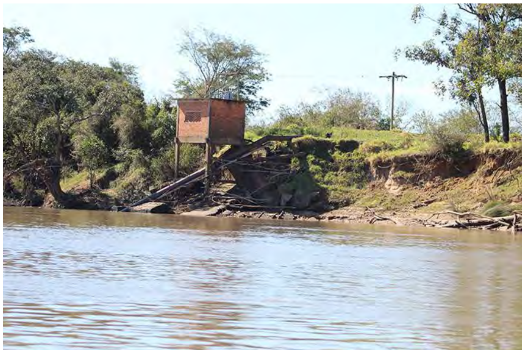
Figura 5.33 – Imagem obtida na margem esquerda do rio Jacuí, ponto 123, ilustrando uma das tantas tomadas d'água existentes.
