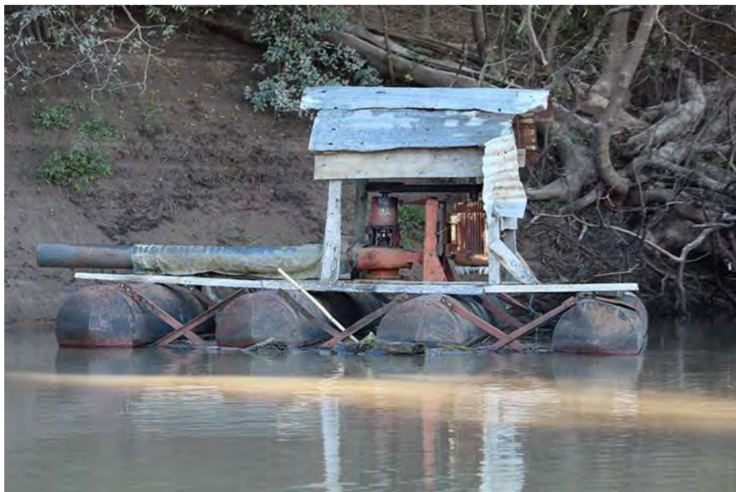
Figura 5.31 – Imagem obtida na margem esquerda do rio Jacuí, ponto 065, ilustrando uma das tantas tomadas d'água existentes.
