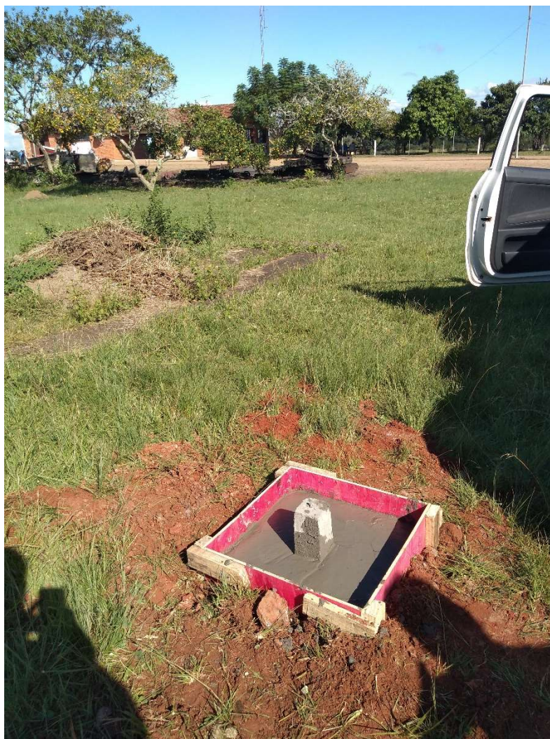
Figura 4.8 – Detalhe da instalação do Marco 10 em Santo Amaro
