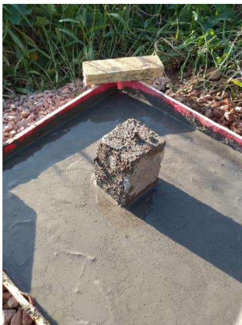
Figura 4.6 – Detalhe da proteção contra intempere, até a pega do concreto (Marco Número 06)
