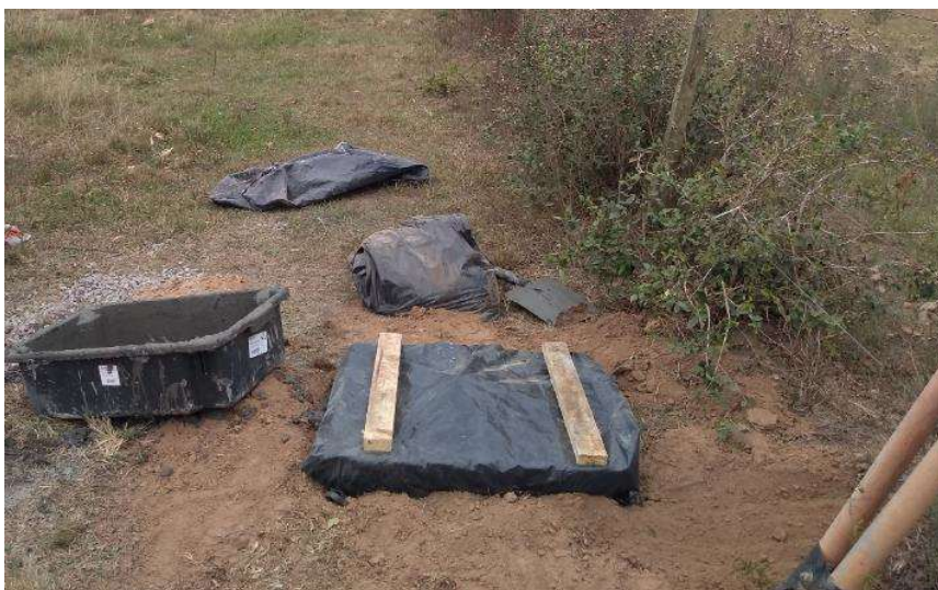
Figura 4.6 – Detalhe da proteção contra intempere, até a pega do concreto (Marco Número 06)
