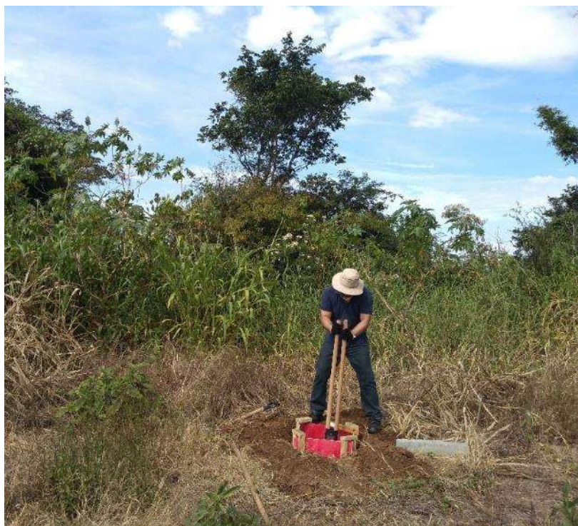
Figura 4.4 – Instalação da forma da proteção lateral (Marco Número 05).
