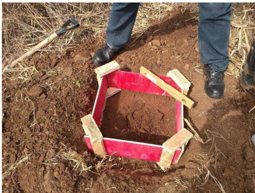
Figura 4.4 – Instalação da forma da proteção lateral (Marco Número 05).
